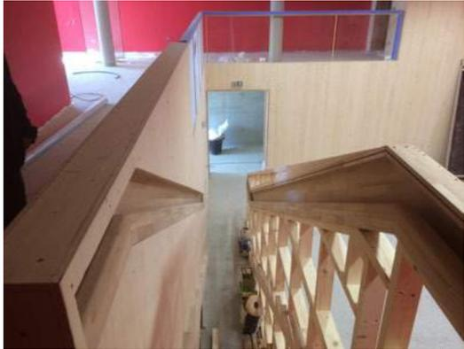
ci-dessus: détail de la rampe avant la pose des marches
